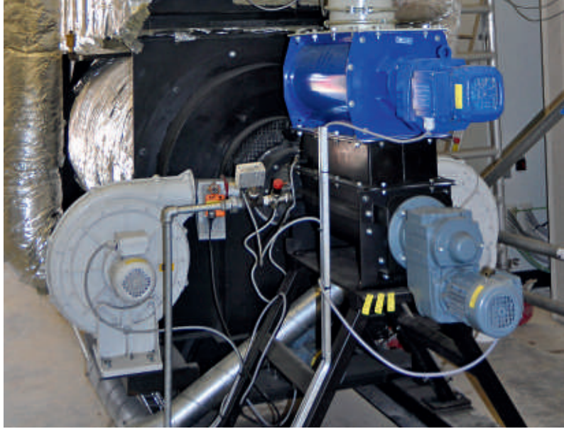
■ Die Brennstoffzuführung ist ab der Zelleradschleuse (blau) standardisiert. Unter dieser befindet sich ein Vorratsbehälter, aus dem die Stokerschnecke befüllt wird. Die seitlich verbauten Gebläse liefern die Verbrennungsluft.
